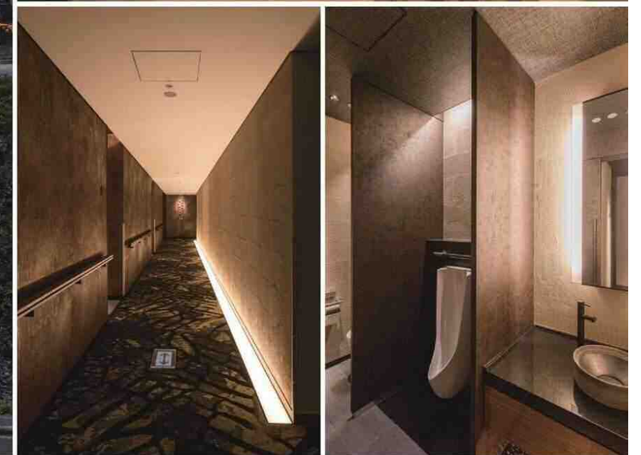
砂壁を意識した、くし引き仕上げのジョリパット。 "Jolyplate" with a combed finish is used in the image of traditional sand-coated walls.
