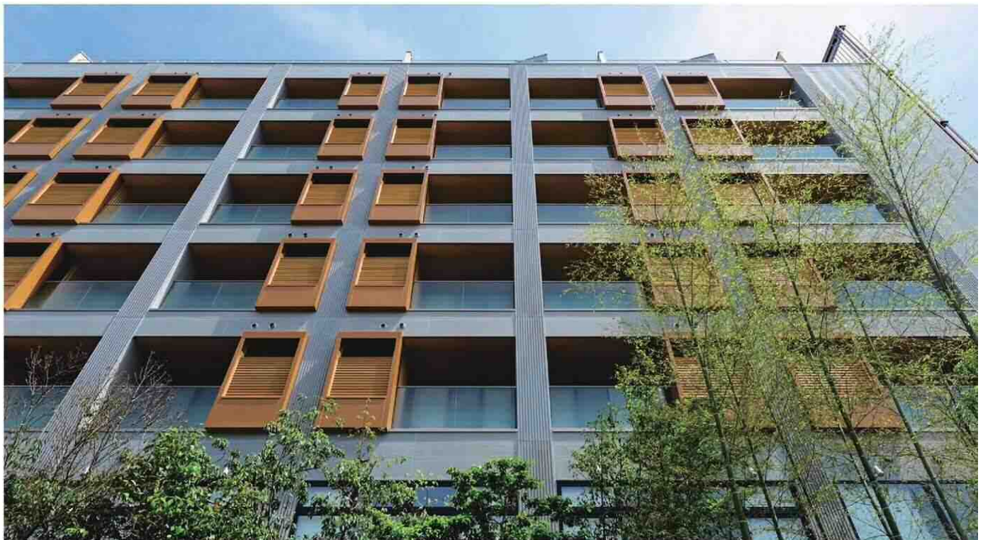
メースをベースとした外壁のアクセントにデザインパネルを採用。 Decorative "Mace" panel applied to accentuate the vertical lines on the facade.
